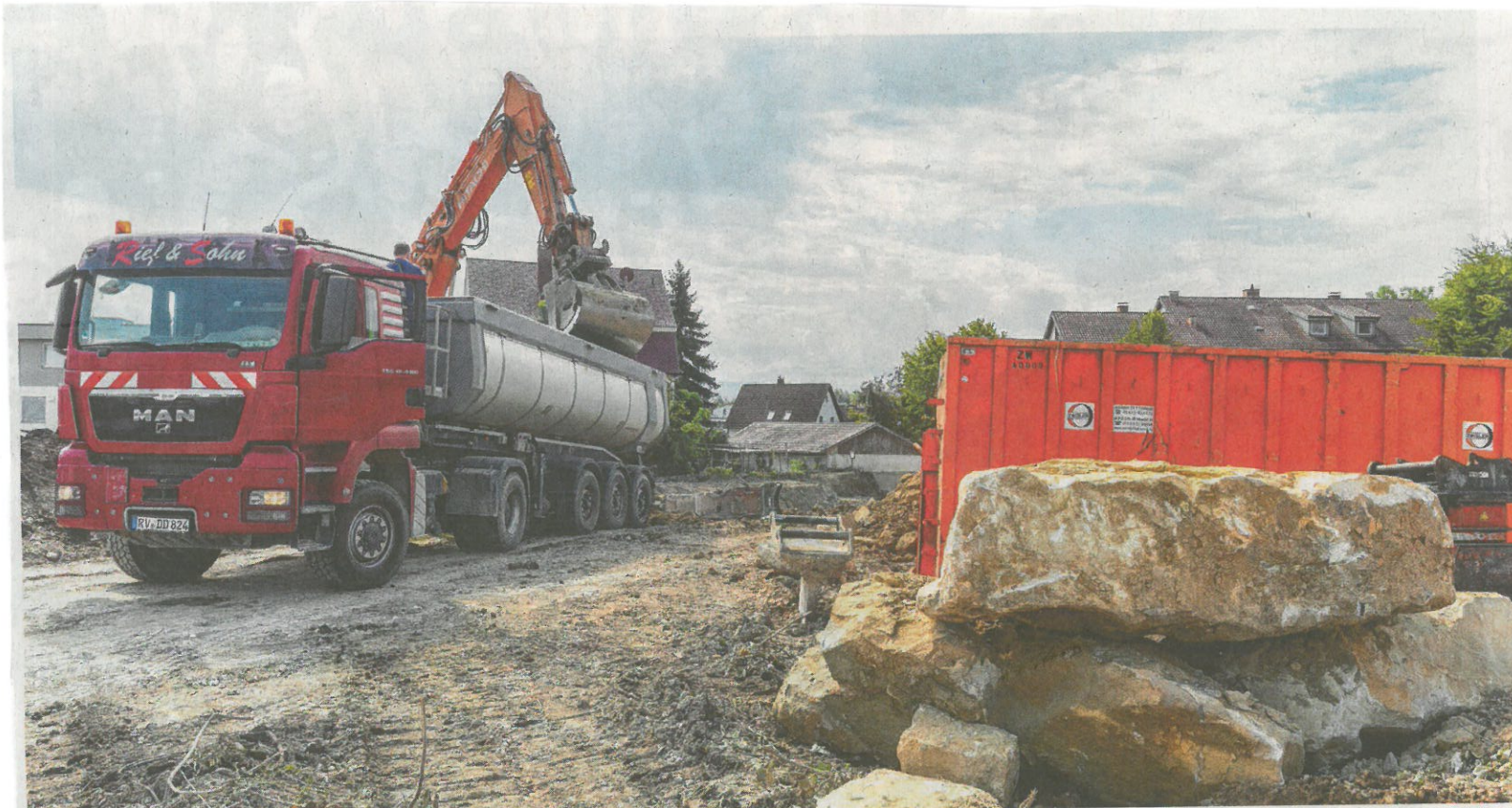
Die GWG hat mit den Arbeiten zur Bebauung des Münchhofareals begonnen.
